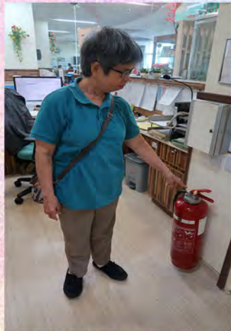
確保消防設備放於中心適當的位置。
